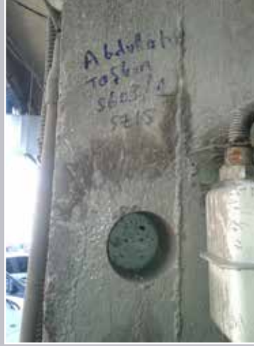
Zemin Kat SZ15 Kolonu Karotu
